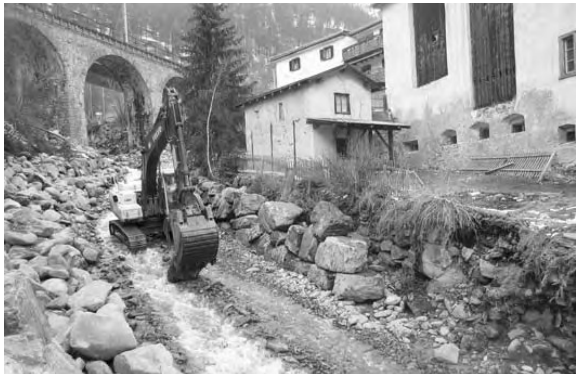
Cun agüd da maschinas as fortifichescha ils cuntschets lung il Lavinuoz per evitar dons vi da las chasas e punts.
